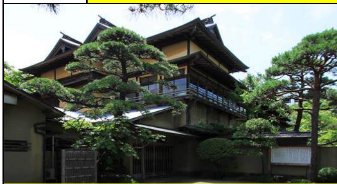
写真① 建物外観
