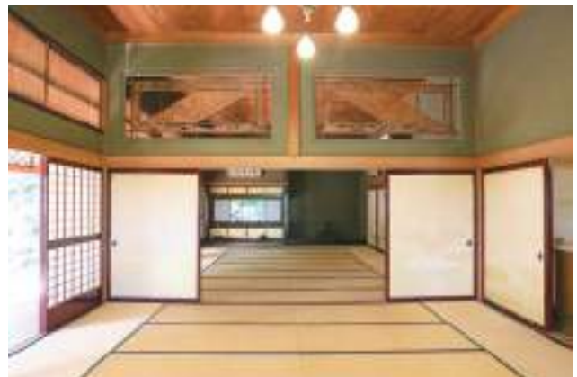
主屋座敷棟 前座敷 欄間
