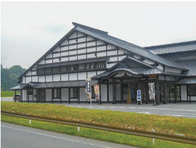
正面玄関：唐破風屋根・建築面積 1,050㎡
