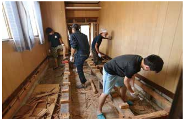
7月 日本中から駆けつけてくれた方々と解体
