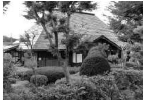
古町通り（先人顕彰館向かい）にある築 267 年の伊藤家
