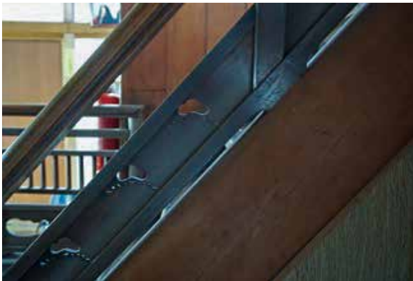
手摺 「松」の透かし彫り
