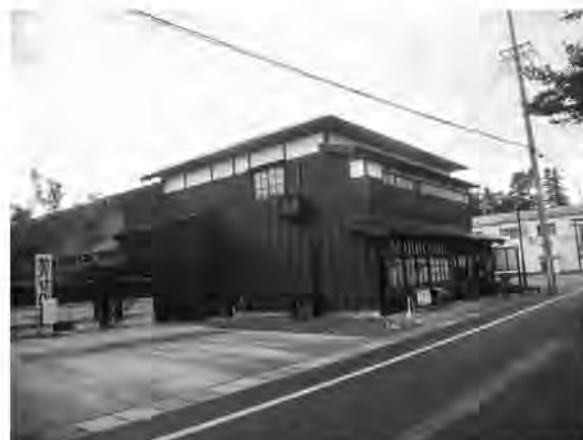
薬局西側・改修後
