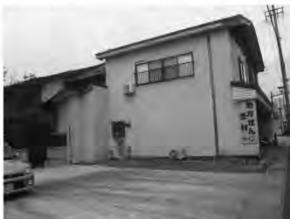
薬局西側・改修前
