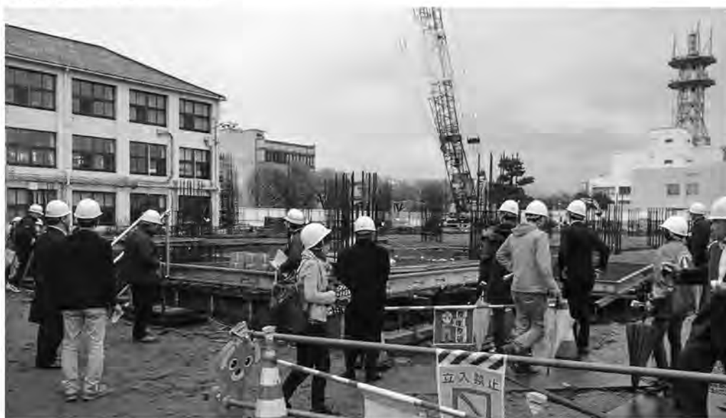
新庁舎の建築主体工事の様子
