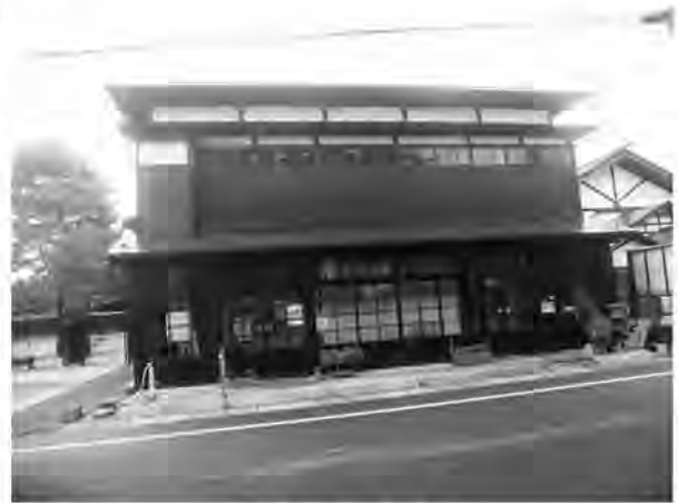
薬局正面・改修後
